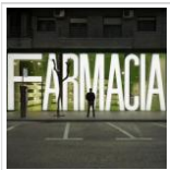
Casanueva Pharmacy / Clavel Arquitectos
